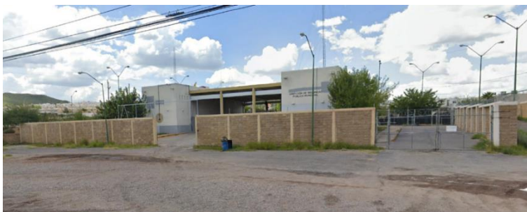
Imagen 78. Estación de Bomberos No. 7.
