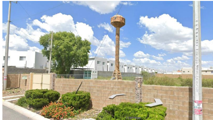
Imagen 41. Tanque elevado Fracc. Andalucía.
